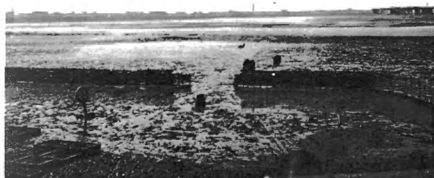
5 mai 1937. Photo Wandels. Vue vers les écluses, prise du hangar ; bassin en vidage.
