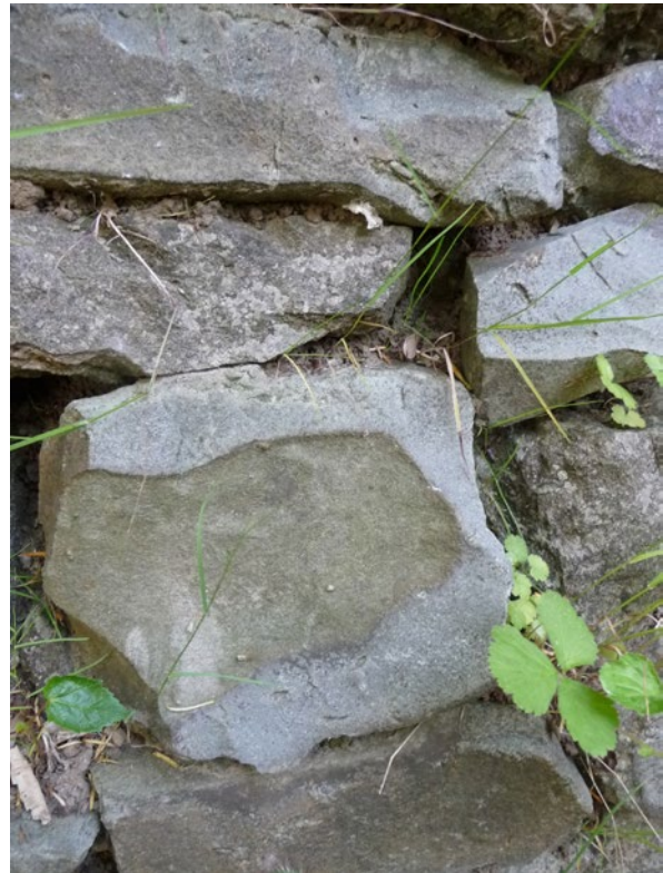
Figuur 21. Droog gestapeld muurtje langs de ‘Muur van Geraardsbergen’ in harde compacte veldsteen.
