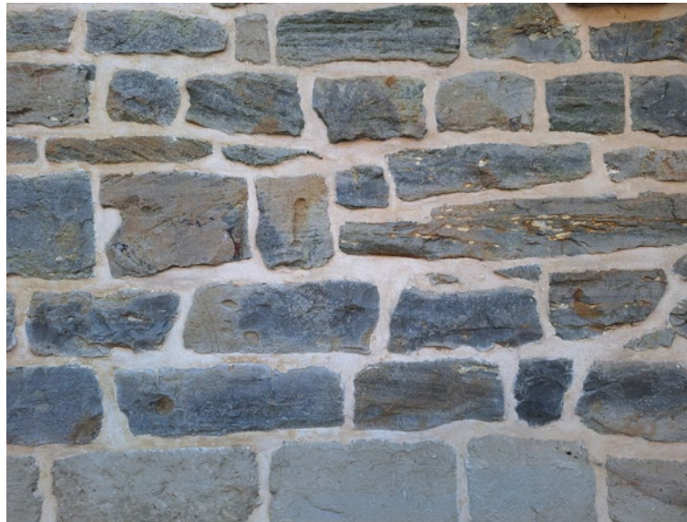
Figuur 12. Veldsteen, met blauwgrijze kleur en bruine oxidatie, gekenmerkt door sterke doch onregelmatige verkiezeling die gelaagdheidsvlakken, bioturbaties en geelwitte klasten (porcelaniet?) accentueert, resulterend in ongelijkmatige stenen, op onderlaag van lichtgrijze Ieperiaanse steen zonder zichtbare nummulieten maar met kalkig-kleiig bindmiddel dat zachtere maar regelmatigere blokken oplevert (Sint-Martens-Lennik).
