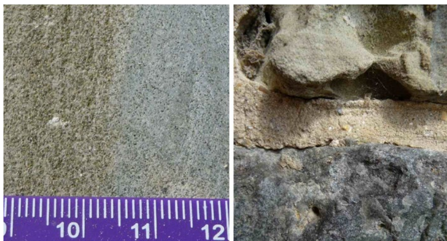
Figuur 5. Links: Etikhove kerk, verschil verkiezeling binnen één steen. Rechts: kerk Bovekerke, bovenaan veldsteen met weinig cementering en verweerd, onderaan sterk gecementeerde veldsteen.
