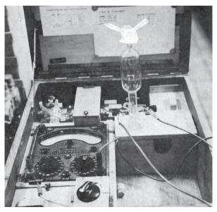
**Figure 3.** L'appareillage électrolytique de Koepf. Dans le bas à gauche, l'ampèremètre ; dans le haut à droite, la cellule électrolytique avec à sa base les deux électrodes.
