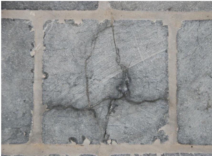
Figuur 8. Platine met een dubbel barstenpatroon, vooreerst de tektonisch gestuurde barsten in een geconjugeerde set dat van boven naar onder loopt, maar eveneens een barst met ondulerend verloop volgens een meer kleiig gelaagdheidsvlak, van links naar rechts in beeld.
