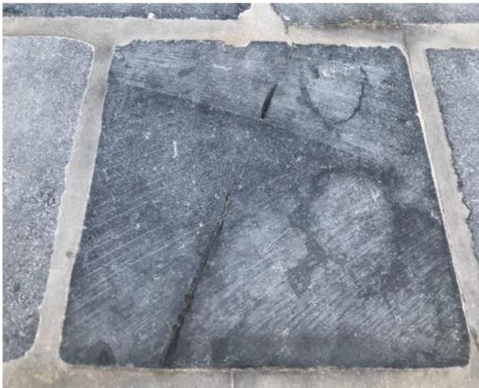
Figuur 11. Voorbeeld van een platine met scherp sedimentair contact tussen donkerder en meer grofkorrelige grainstone in het midden met blekere iets fijnkorreliger grainstone bovenaan (het gebruikelijke type), met nodulair vervormd contact met meest fijnkorrelige grainstone anderaan. Een rechte tektonische voeg, deels opgevuld als een calcietader, is deels halfopen, zonder vochttopslorping, deels met vochttopslorping en al gedeeltelijk doorgebroken zoals de breuk door de cementvoeg bovenaan aantoont. Mettertijd zal deze platine in twee breken.
