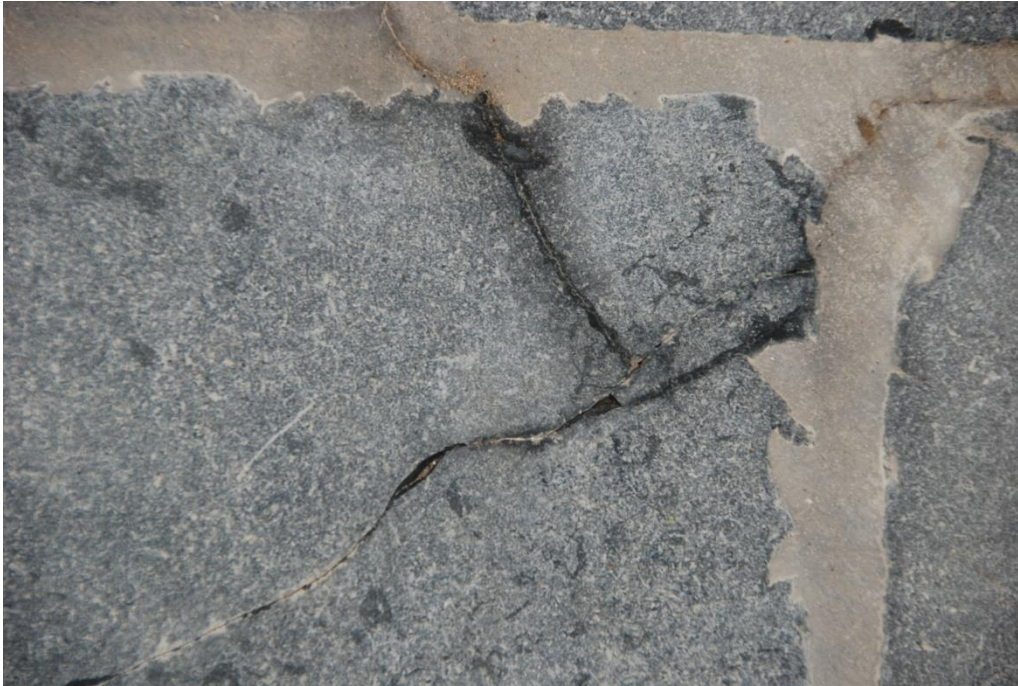
Figuur 10. Halfopen barsten die enkel vanaf de randen van de platine vochttopslorpend zijn, zoals aangegeven door de donkere kleur. Mogelijk zijn deze barsten verwijfd door het behouwen van de rand van de platine waardoor ze gemakkelijker vocht opnemen. Het leidt echter geen twijfel dat mettertijd de open, vochttopslorpende barst zich zal voortzetten over het nu nog halfopen deel van de barst, die initieel van tektonische oorsprong is, en dat deze platine ook gaat splijten.
