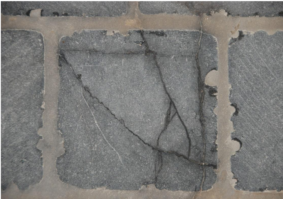
Figuur 6. Kenmerkend patroon van barsten in een platine, klaarblijkelijk gestuurd door de tektonische vervorming die het gesteente heeft ondergaan en die ook wordt gevolgd door de fijne witte aders (van boven naar onder en van links boven naar rechtsonder in een patroon van geconjugeerde richtingen die een hoek van ca 37° maken).
