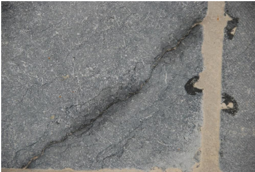
Figuur 2. Korrelig uitzicht van een bioklastische kalksteen of grainstone, met talrijke fijne kleihoudende voegjes volgens de oorspronkelijke lagenopbouw van het sedimentair gesteente (diagonaalswijs in beeld). De donkere verkleuring langs de belangrijkste voeg wijst op vochtabSORPTIE en risico op barstvorming.
