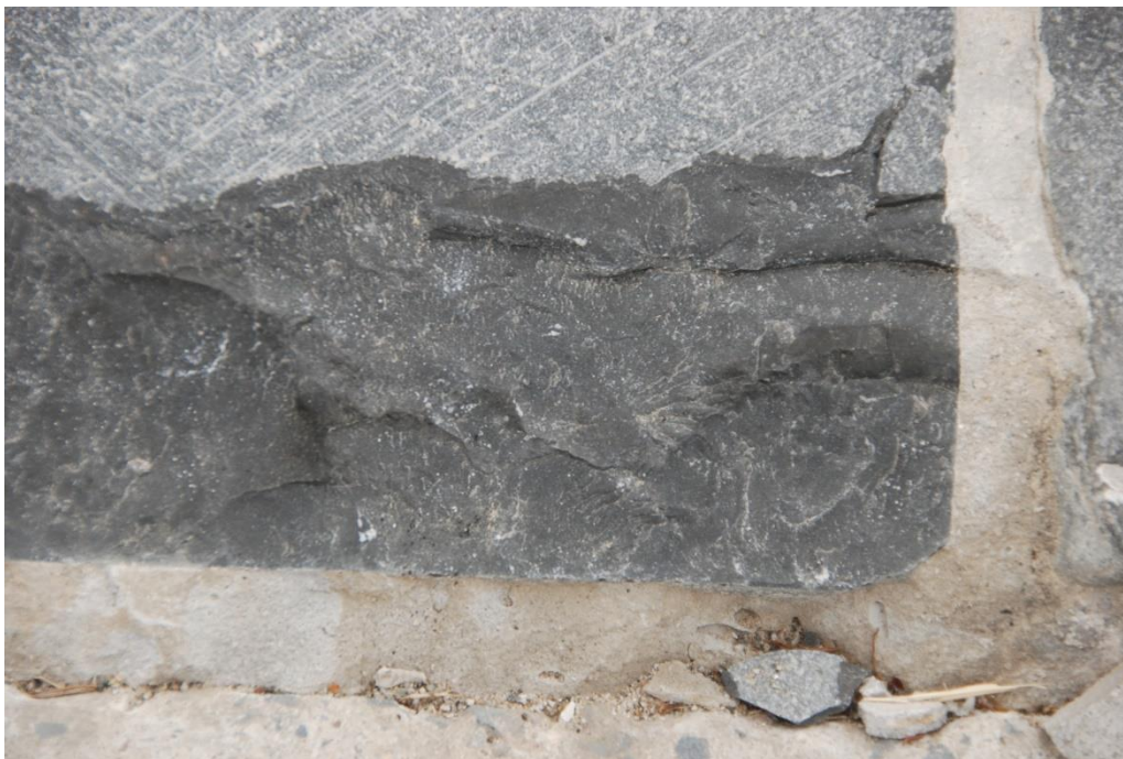
Figuur 4. Donkergrijze boord van een platine die overigens in grainstone is, met tijdens het doorzagen afgesprongen schubben, wijzend op een verkiezeling of chertlaag, frequent als insluitsel voorkomend in kalksteen, maar normaliter als steenafval beschouwd.
