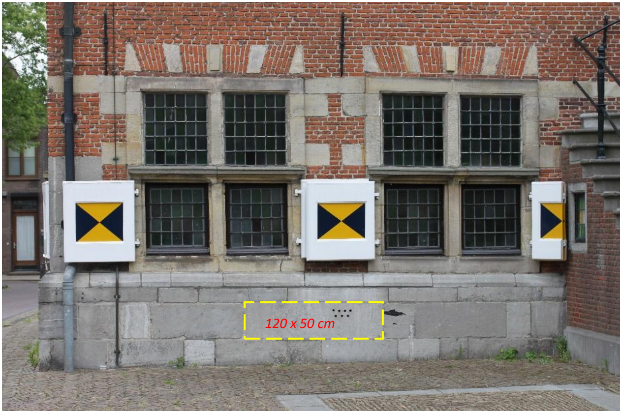
Fig. 6. Voorzijde: Onderbouw en plintlijst in Maaslandse kalksteen
