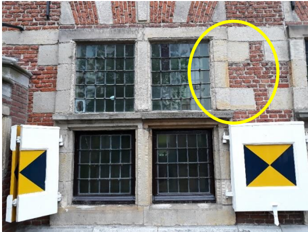
Fig. 18 Kruiskozijs in Obernkirchener zandsteen met Liesegangringen.
