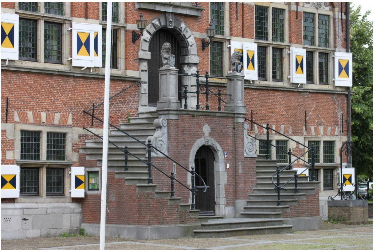
Fig. 7. Deuromlijsting, voluten en konsolen in Maaslandse kalksteen
