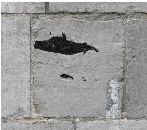
Parementsteen voorzijde stadhuis Maaskalksteen waarin chert (L= 24 cm)
