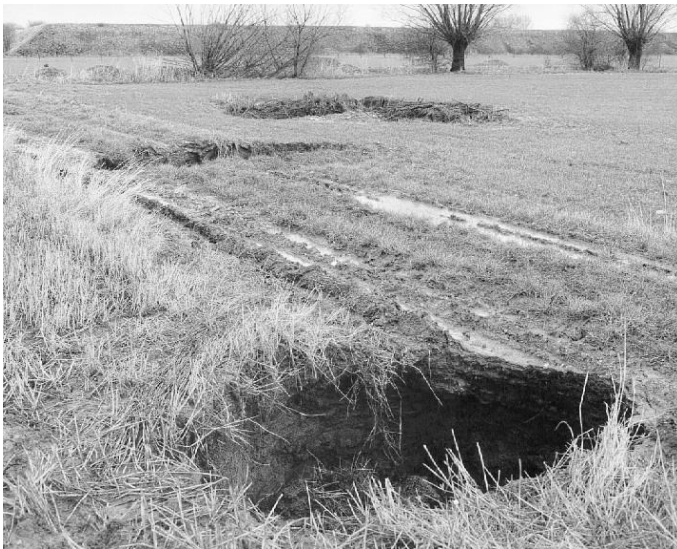
Instortingsholtes te Gaurain-Ramecroix (Doornik), 1995, gevolg van diepe bemaling in de nabijgelegen kalksteengroeve en ontwatering van instabiele sedimenten die fossiele grotten hadden opgevuld.
