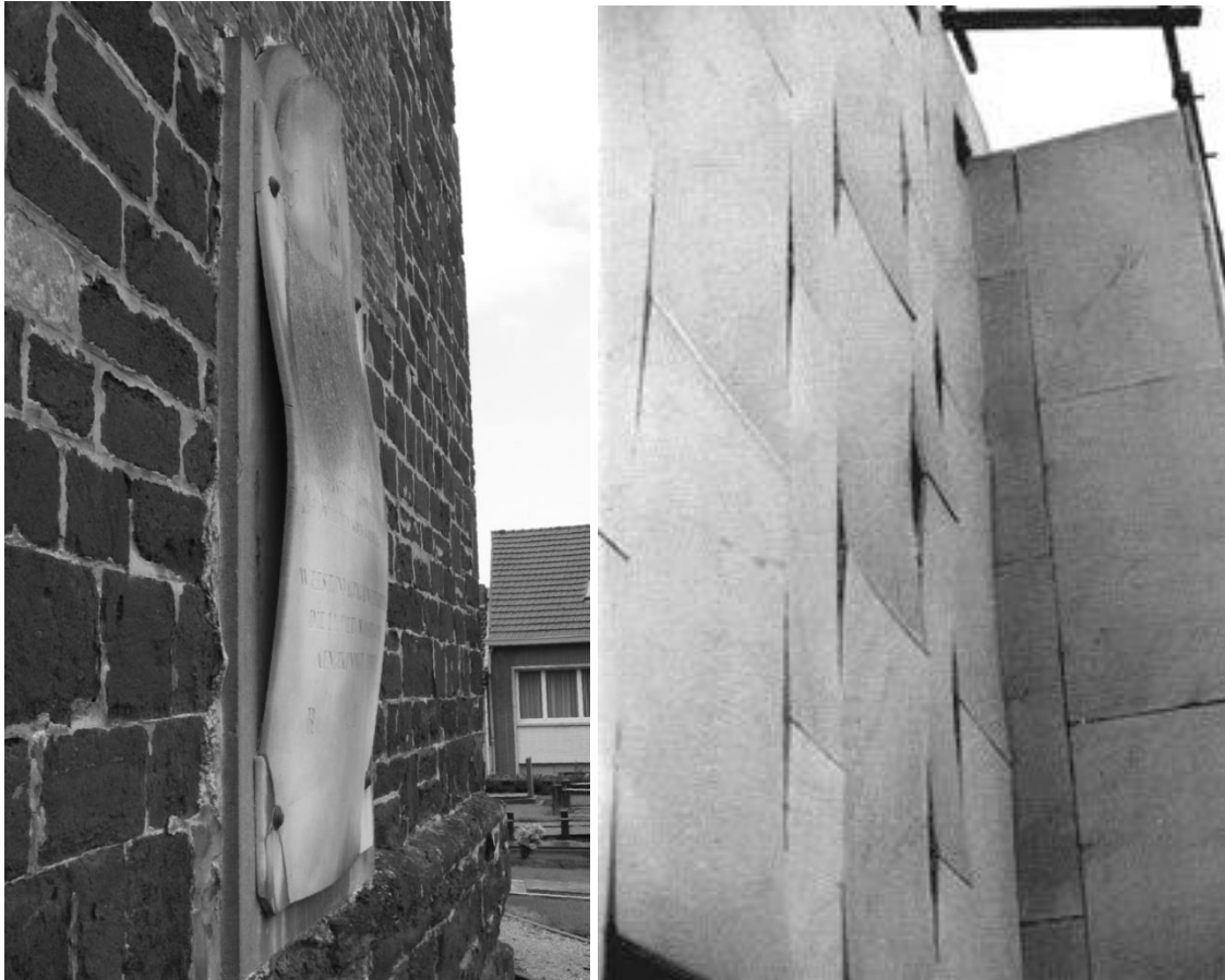
Doorbuigen van dunne platen in wit Carrara-marmer met suikerige (granoblastische textuur): epitaaf St.-Catharinakerk Kortrijk-Dutsel (links) en gevelbekleding Finlandia House, arch. Alvar Aalto (rechts).
