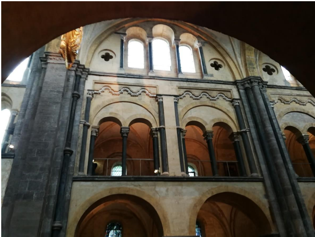
Pilasters en bundelzuilen in Maaskalksteen, opgedeeld in grote massieve blokken die grijs aftekenen tegen het gele mergelstenen binnenparement.
