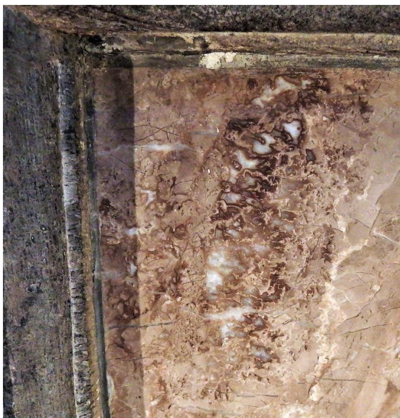
Detail van de marmerplaat in bleekbeige Napoleonmarmer uit de Boulonnais (Noord Frankrijk). Dit is een rifkalksteen die als een breccie is opgebroken.
