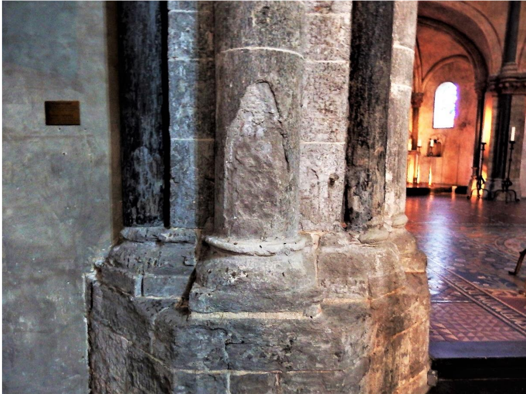
Bundelzuil tussen noordertransept en koor in grijze Kolenzandsteen die grof afsplijt, vermoedelijk als gevolg van een plaatsing tegen groefleger.
